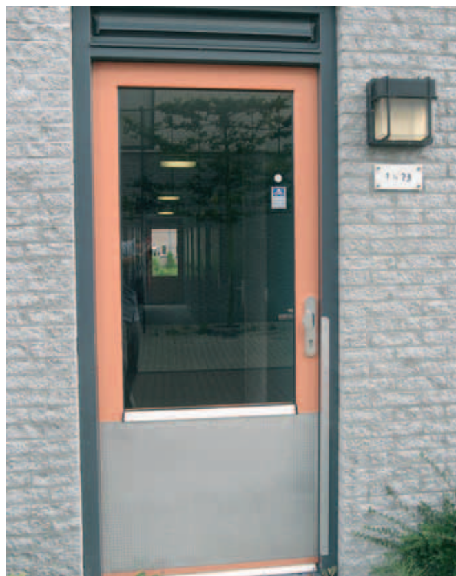
Doorzicht en licht in bergingsgang
