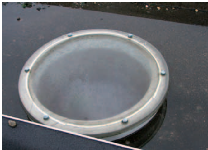
Een lichtkoepel op een uitbouw is veelal een bereikbaar dakelement
