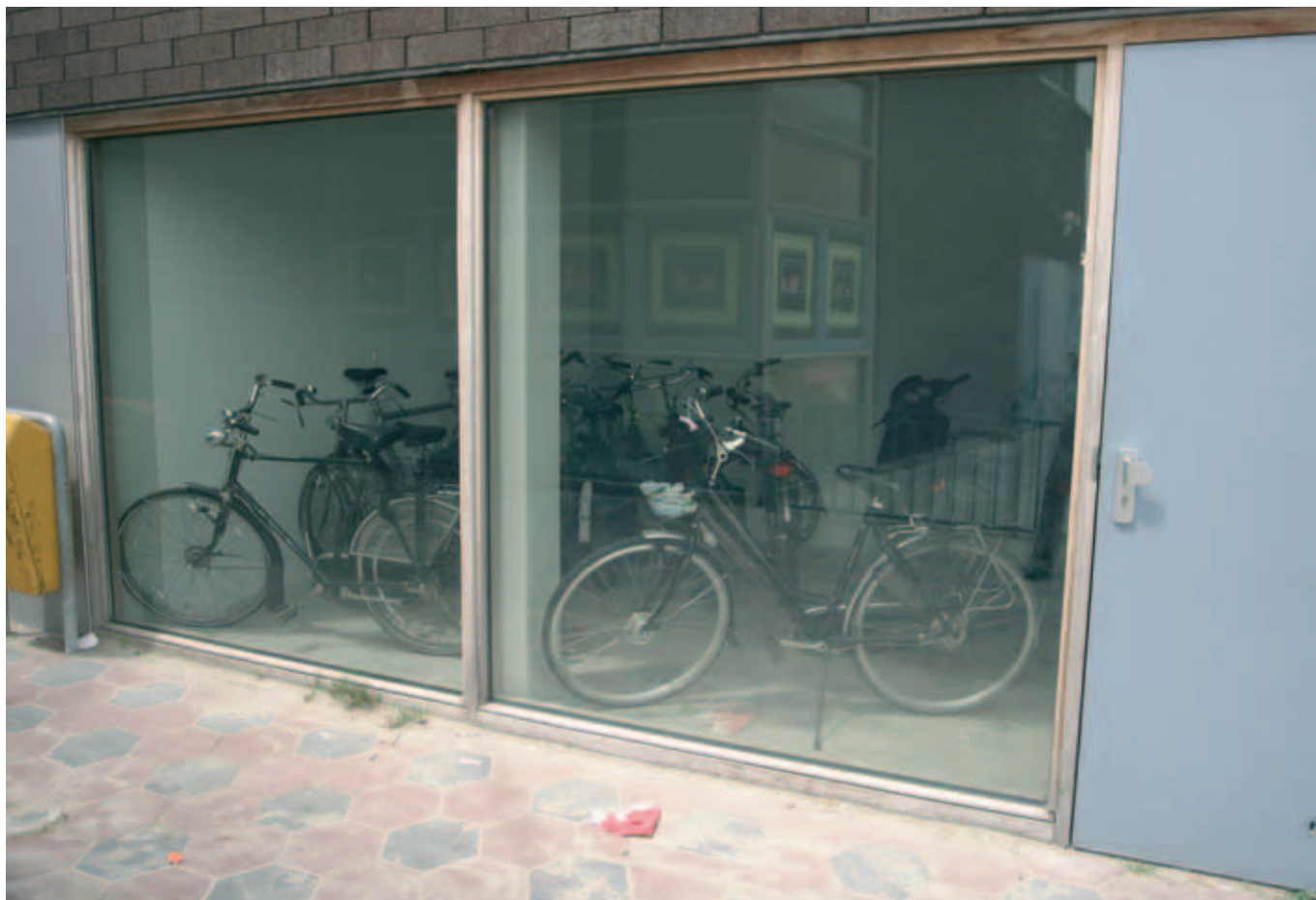
Dit is geen gewenste situatie. Let op: het glas direct naast deze toegangsdeur dient minimaal P4A te zijn en bij voorkeur is er geen zicht op de fietsen/scooters van buitenaf.
