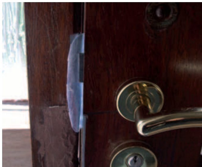
Indien de deur niet op het nachtslot zit, kan de dagschoot eenvoudig worden "geflipperd" met een stuk plastic
