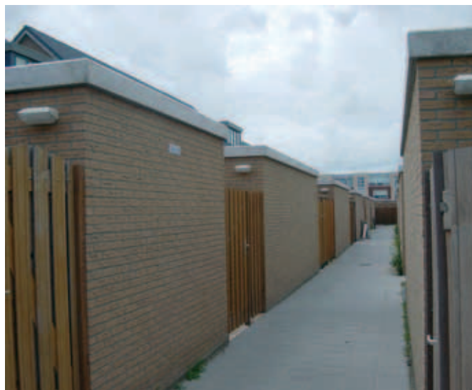
Verlichting op deze wijze binnen dertig centimeter van de erfgrans en maximale onderlinge afstand van twaalf meter
