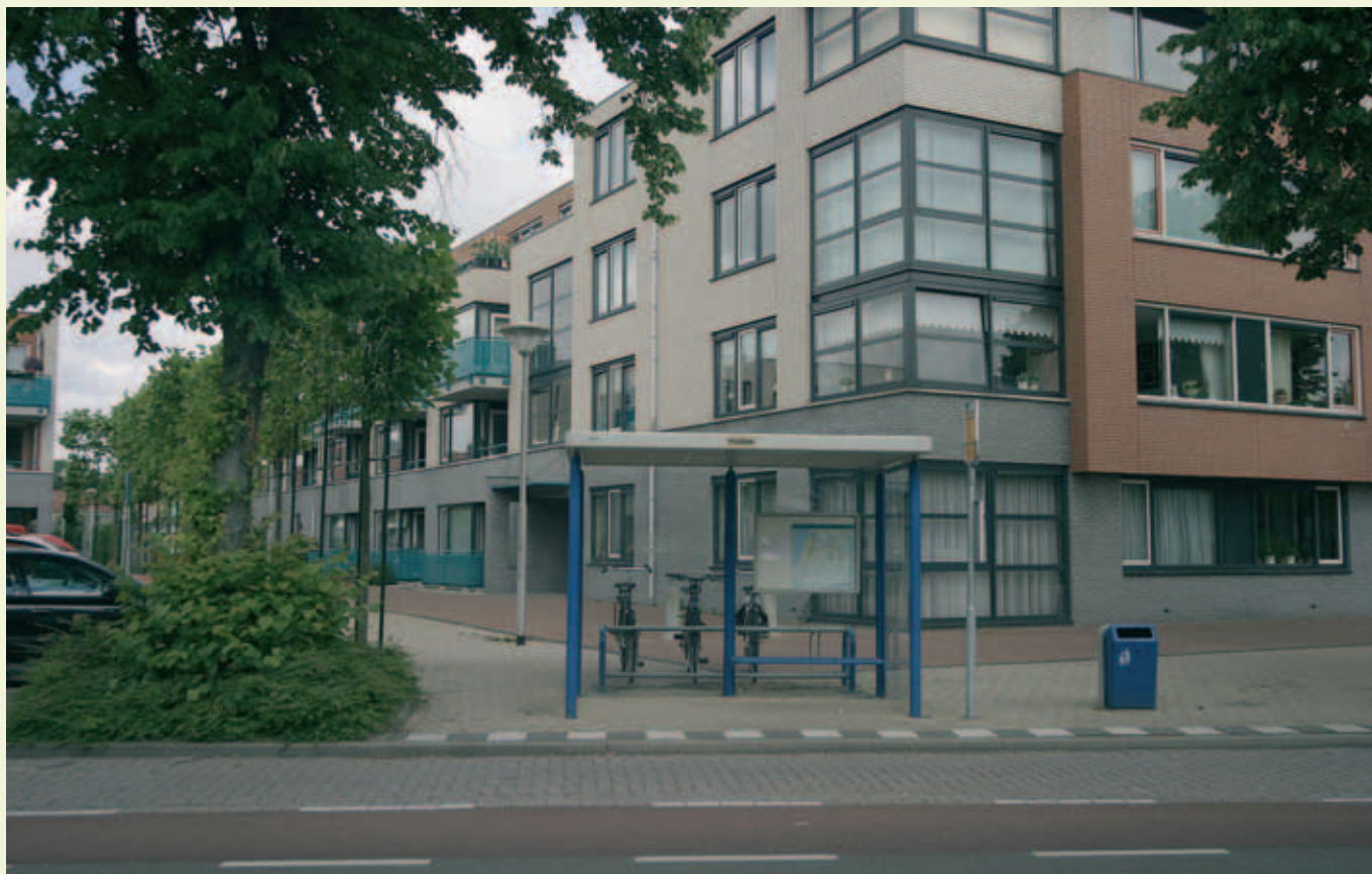
Dit bushokje ligt goed in het zicht van woningen
