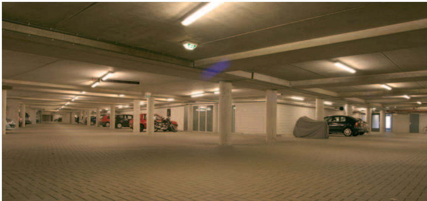
Een garage moet overzichtelijk en goed verlicht zijn
