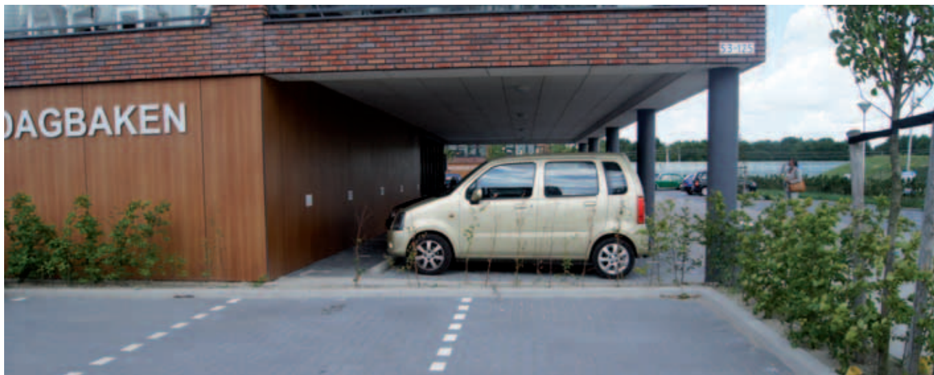
Parkeren in de plint van een gebouw wordt steeds vaker toegepast. Ook hierop dient zicht te zijn vanuit minimaal twee woningen.
