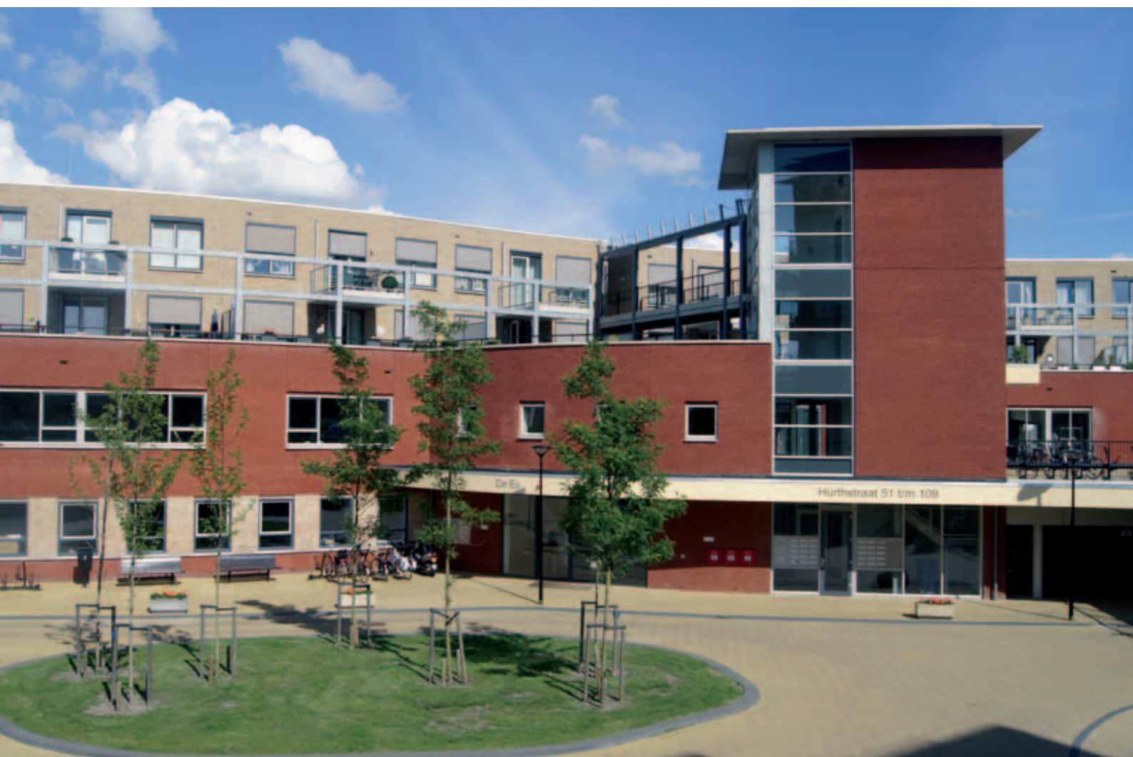
Gebouw waarin woon- en zorgfunctie is gecombineerd
