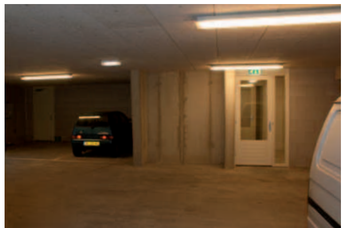
Hier blijkt dat men vanuit de centrale hal onvoldoende zicht heeft op de naast de deur geparkeerde auto. Dit kan worden opgelost door het plaatsen van een spiegel, zoals ook in de leidraad staat.
